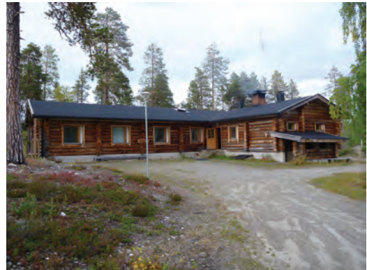
Kenttälammin kämpä Sallan Naruskassa.
